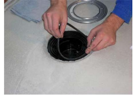
3. Bauschutz entfernen und Dichtflansch reinigen, Dichtring in die Ringnut des Dichtflansches einlegen
