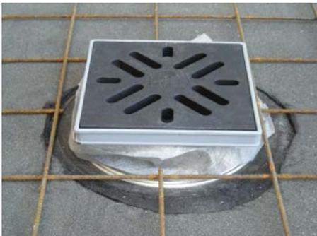
7. Aufstockelement mit Filtervlies ummanteln und Baustahlgitter auflegen
