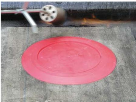
4. Zweite Bitumenlage mit Bitumenkragen des Ablaufes verbinden
